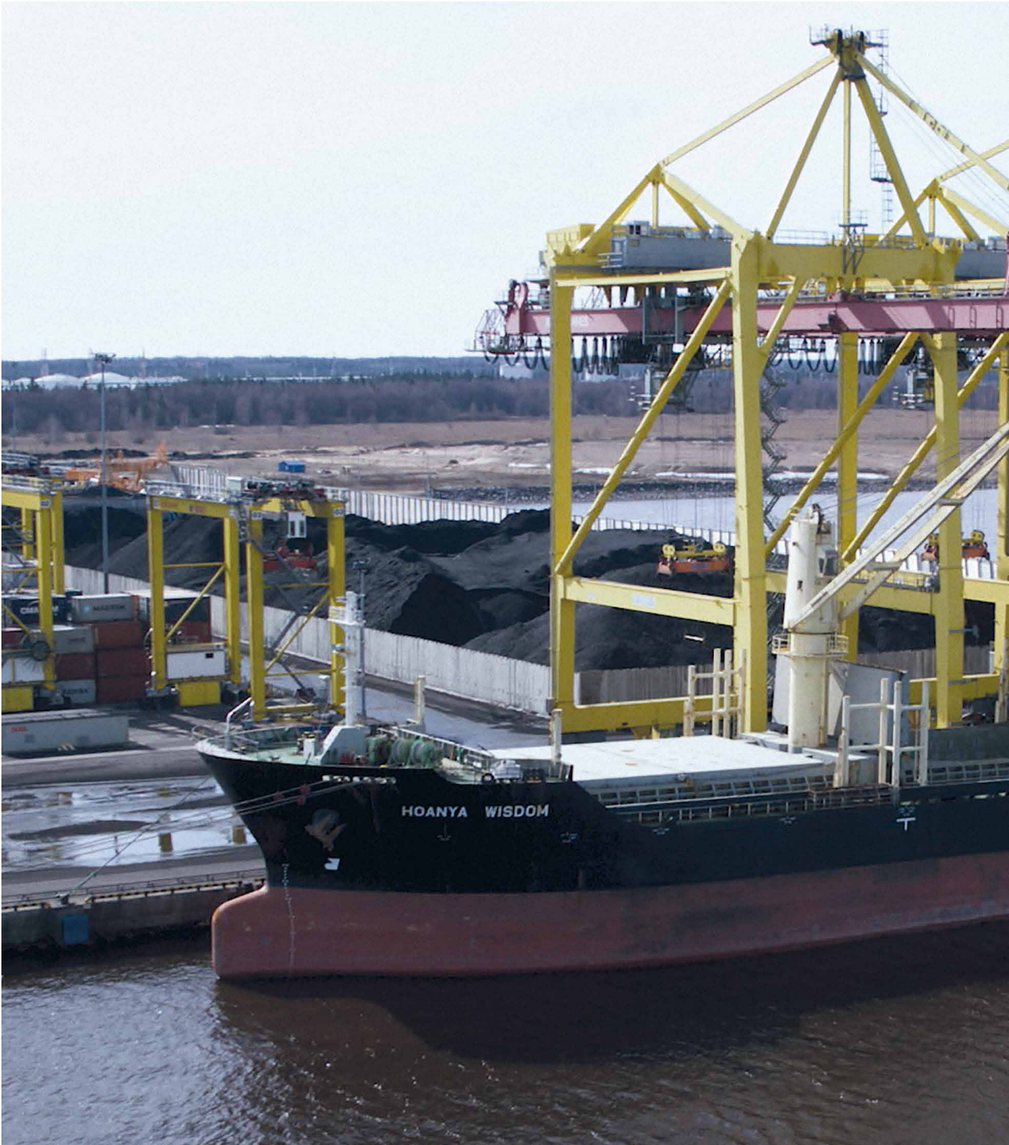
Kohleumschlag am Ust-Luga Container Terminal.
